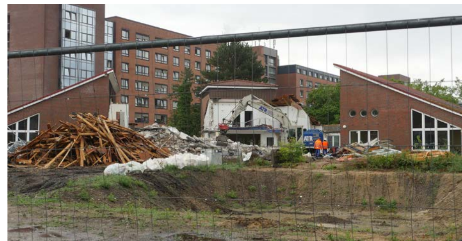
Der Abriss läuft, manchmal muss gar nicht so Altes dem Neuen weichen.
